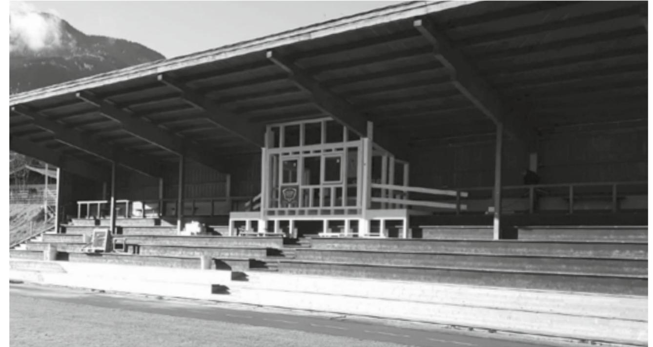
Im Mai 2022 wurde das Kassa-/Kiosk-Gebäude durch die SCM-Sektion Fußball in Zusammenarbeit mit dem Stadtbauhof abgerissen. Nach dem Abriss der inneren und äußeren Schalung der Kiosk-Hütte zeigte sich, dass die im Erdkontakt befindlichen Elemente fast alle durchgemorscht waren und die gesamte Statik (Steher und Träger) vollständig erneuert werden musste. Deshalb entschlossen sich der SCM und der Bauhof Mittersill für einen Vollabriss des Sprecherturms und des Kiosks.
