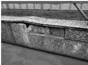
Unsere Tennisplatzmuer wird nach einem Gemeinderatsbeschluss noch in diesem Frühjahr durch die Stadtgemeinde saniert werden. Wie man auf dem Foto sieht, sind aktuell die auf den alten Mauerkern aufgebrachten Waschbetonplatten vertikal und horizontal durch Frostschäden stark beschädigt.
