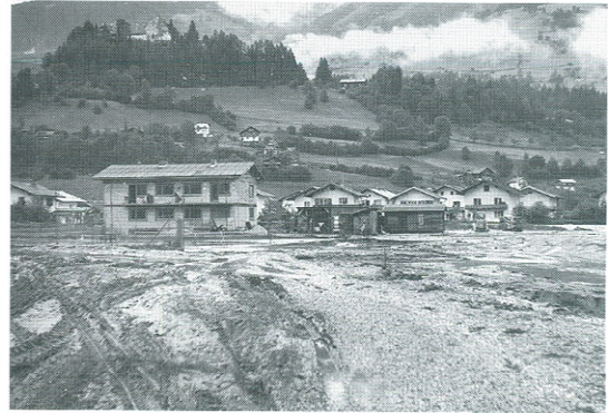
Der Felberbach hat »ganze Arbeit geleistet«: Der Rohbau des Sportheims steht in einer völlig von Schlamm, Schotter und Steinen zerstörten Fußball- und Tennisanlage.
